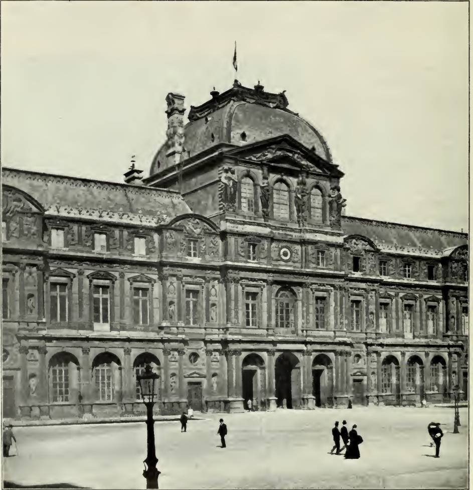
Abb. 61. Teil des Louvre. Links ein Stück von Lescotts Fassade, in der Mitte der Uhrpavillon von Lemercier, rechts Lemerciers Fassade nach Lescotts Muster.
